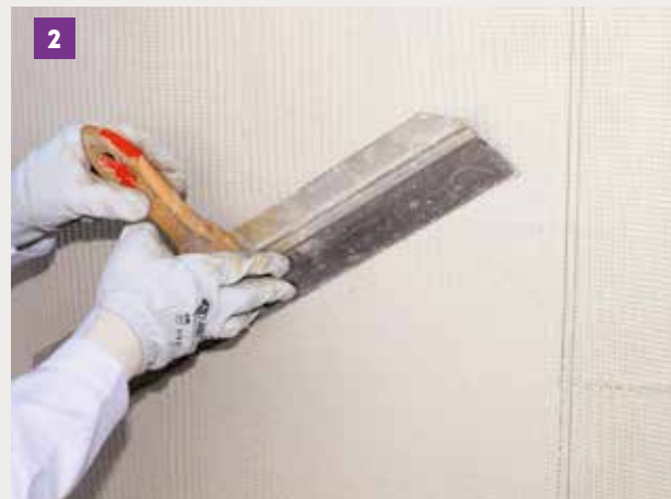
Lissage de l'enduit
