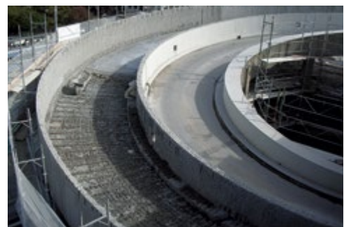
Rénovation du béton Page 24
