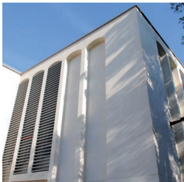
2 PARINTER RÉNOVATION utilisé sur béton
